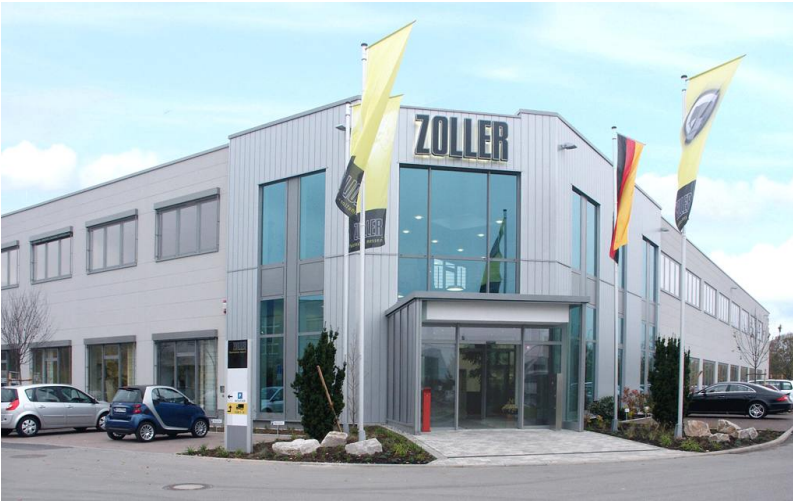
Frontbereich und Eingang des Gebäudes.
